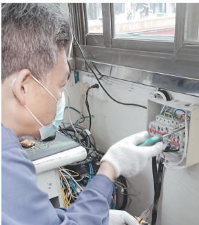
此次专项排查，及时消除了用电隐患，避免了用电高峰期因超负荷运转发生的危险。同时，规范了各类安全标识、警示标识，有效确保社区的用电安全。 筱 静 上图 工作人员在排查电路。 筱 静 摄
