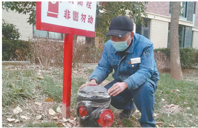
工作人员在给消防栓穿“棉衣”。 王 倩 摄
