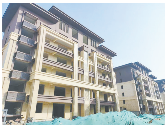
飞天·时代锦苑项目施工现场。
