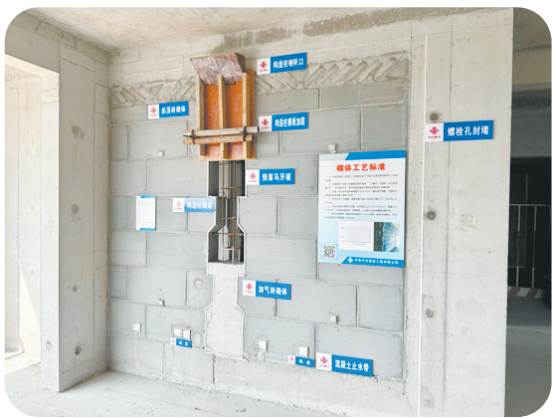
施工工艺样板间将隐蔽工程、工艺工法细致透明展示出来。 刘旭摄
