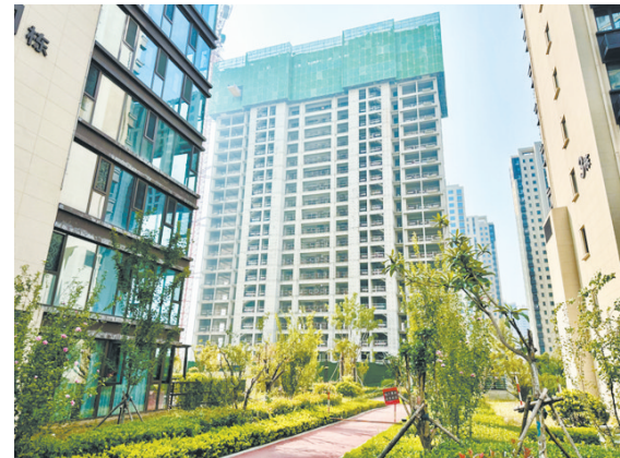
博园·澜庭叙项目三期正在加紧施工中。
