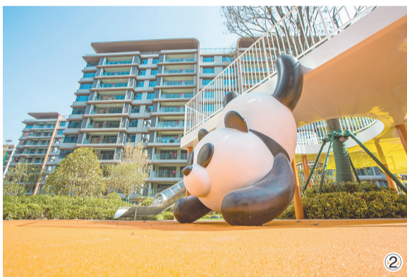
图①② 焦作建业新筑项目实景图。 韩静森 摄
