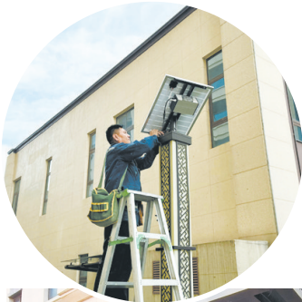
物业人员在调试太阳能灯。孙茜摄
