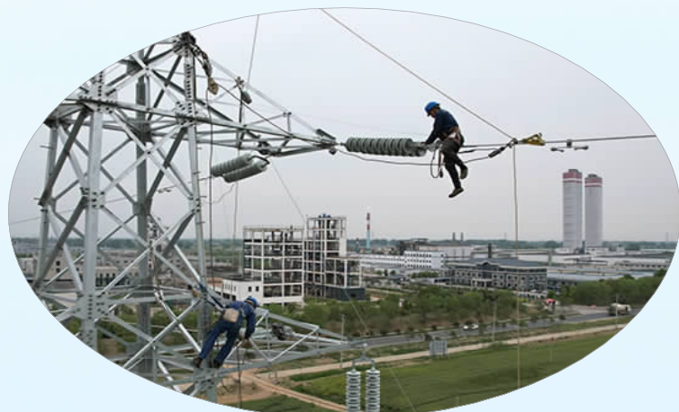
为重点项目架设供电线路
