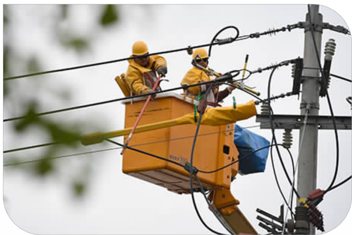
开展带电作业
