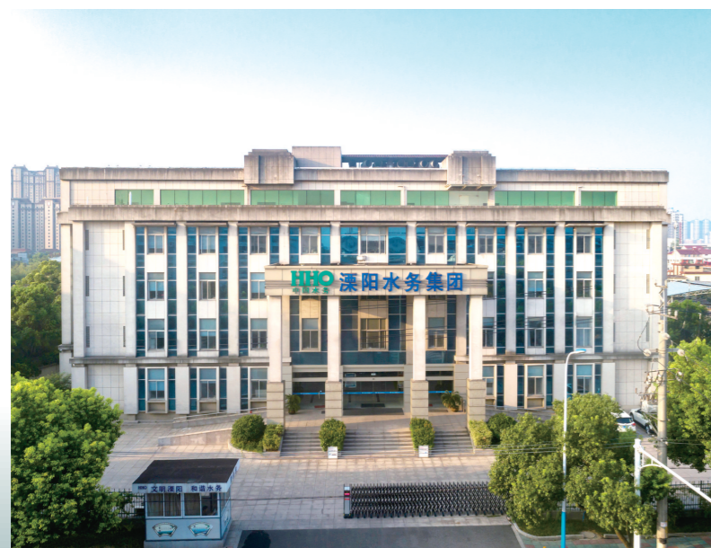
溧阳水务办公楼
