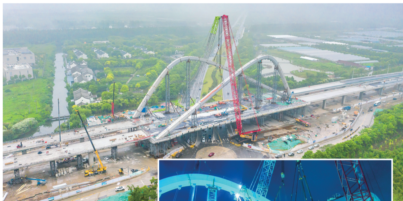
▲临港大道景观桥呈现出翼展碧海、腾飞万里的形象。 ▶为避免影响各项交通，跨临港大道景观桥吊装在晚上进行施工。 □临港城投供图
