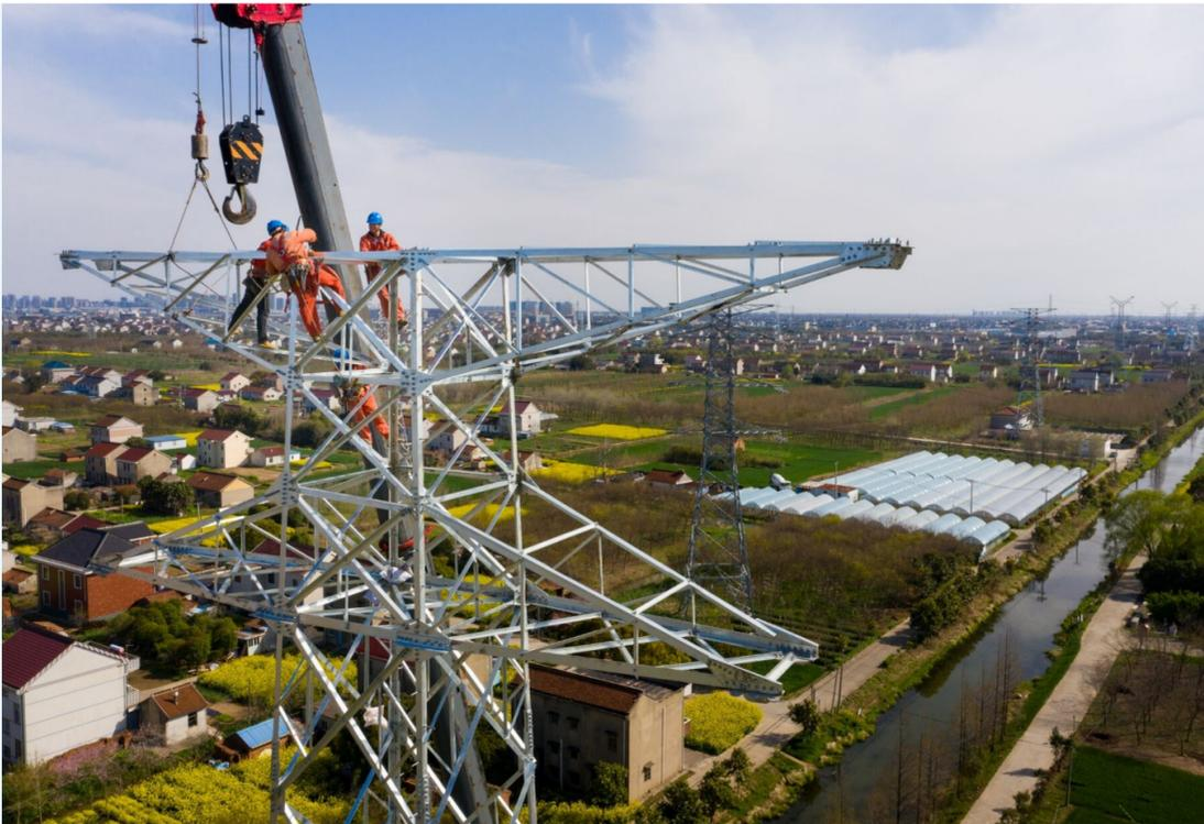
3月29日,电力施工人员在王鲍镇合南村湾洪东路进行高空作业。为全力确保迎峰度夏期间为用户提供安全稳定的用电环境,国网南通供电公司于2021年11月26日起实施南通六区——红阳港220千伏线路改造工程,目前该工程塔基已基本完成,正在全力组立铁塔。工程预计于6月5日竣工投运,届时将切实提升我市电力调配能力。
