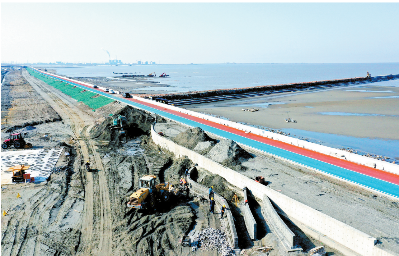
修复海岸带 江海瀾湾度假区海岸带保护修复工程北起高枝港,南至塘芦港,通过盐碱湿地生态修复和海堤生态化建设,形成一定规模的生态减灾空间,实现海岸带生态功能与防灾减灾的协同增效。工程建设内容包括海平台、海堤生态化车道、堤顶拓宽、绿化护坡等。工程于去年10月开工,预计今年5月底完工。图为4月6日保护修复现场。融媒记者 潘杨摄
