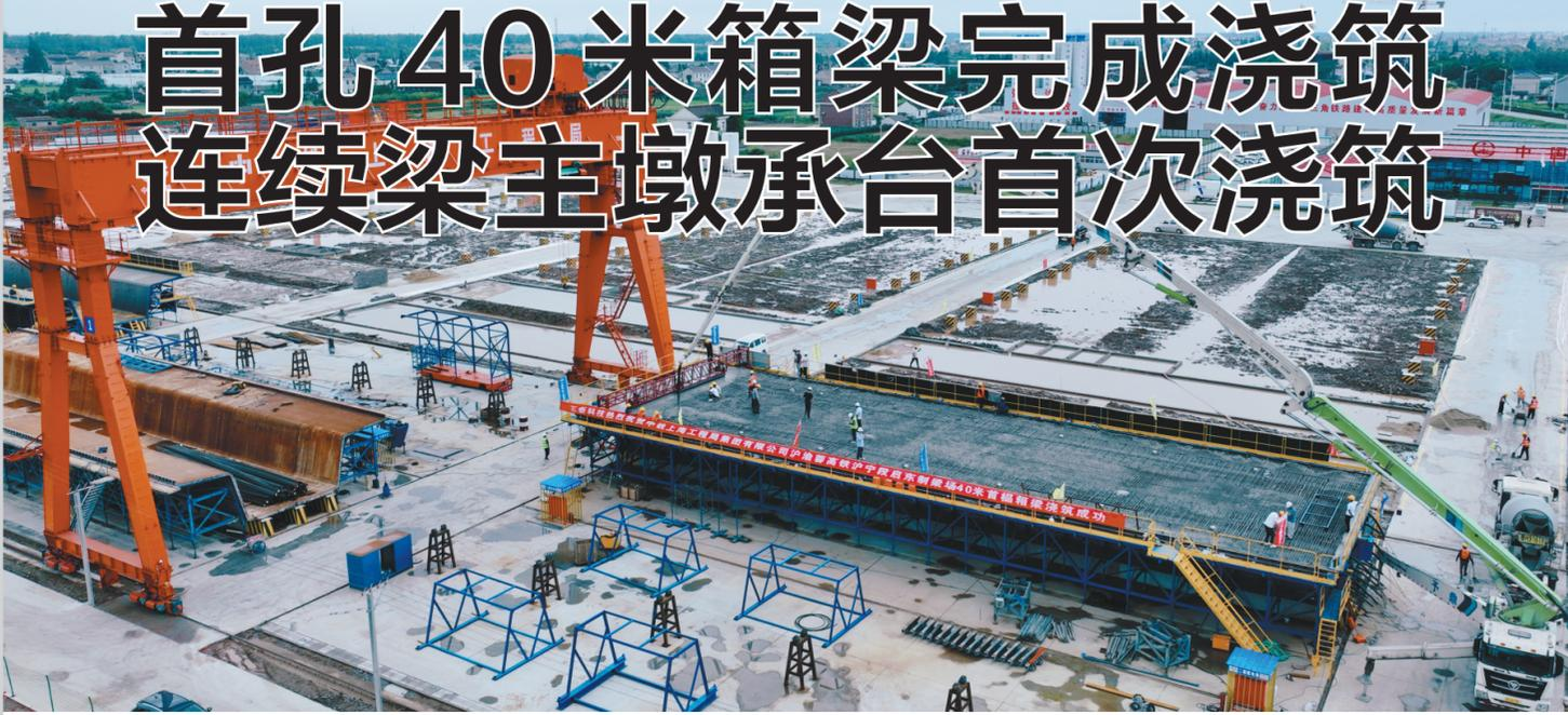
本报讯 7月7日,随着371方混凝土全部完成浇筑,北沿江高铁首孔40米箱梁顺利完成浇筑(如图),这也是中铁上海工程局启东制梁场完成浇筑的首孔箱梁,标志着启东制梁场正式进入箱梁预制生产阶段。
