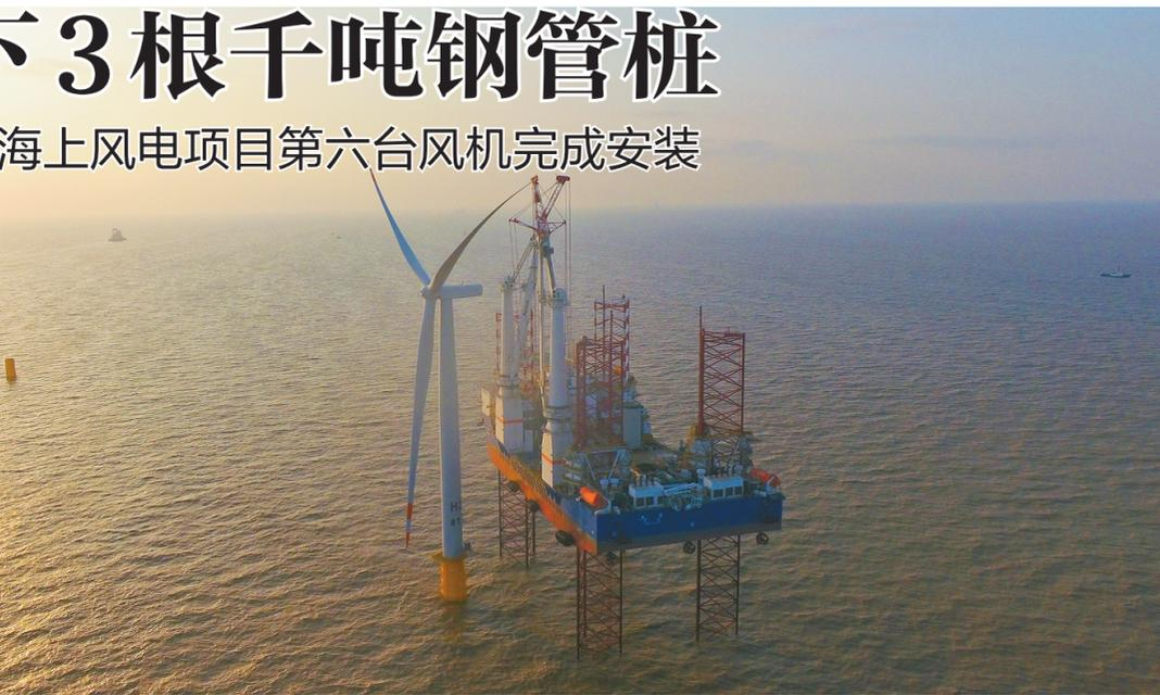
毂组合体倒驳,剩余的两只叶片倒驳以及三节塔筒与机舱安装,最终在3月13日凌晨圆满完成最后的叶片吊装工作。
