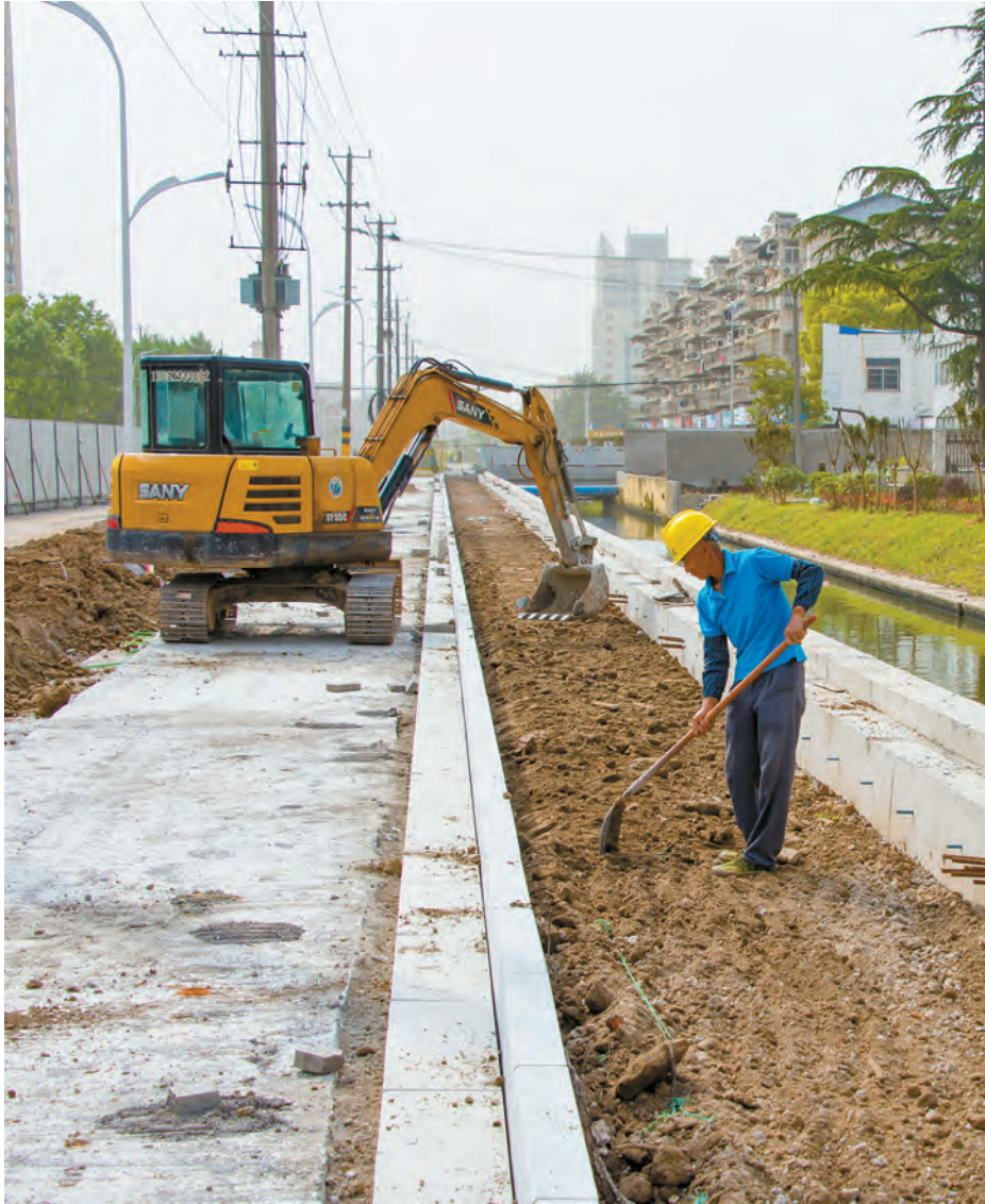
5月8日,市区紫薇河综合整治与紫薇路综合改造两大工程接近尾声。目前紫薇路人行道插板桩工程已结束,工人正在进行道路砂石回填和混凝土路面浇筑,预计6月中旬完工。融媒体记者 姜雨蒙摄
