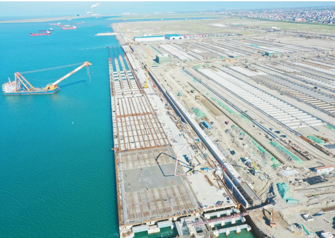
5月17日,长812米、宽42米的2+2码头项目A标段8#-9#泊位码头前平台进行面层浇筑。
