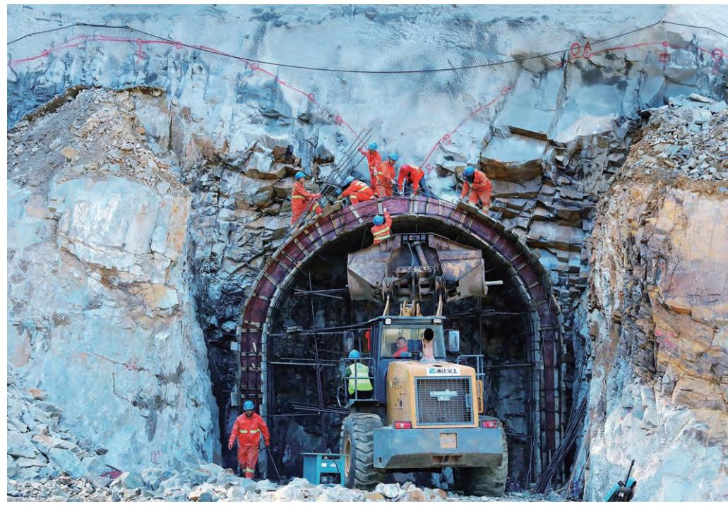
528国道新路湾至石练段改建工程杨家隧道正在进行中导洞护拱基础挖方。目前,528国道新路湾至石练段改建工程进展有序,其中,新路湾隧、杨梅坪隧道、杨京隧道、马鞍山隧道等都已进入隧道进洞施工阶段。
