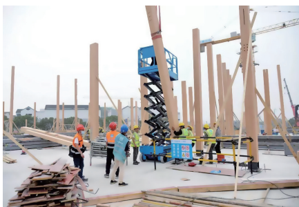
“一叶扁舟”效果图。 ▲工人进行木结构施工。
