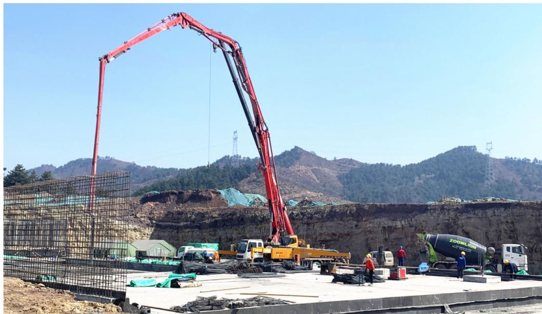
大水网永和水库供水工程是沁河沁源段生态综合治理项目的重点工程,也是县委、县政府解决县城及沿线居民用水问题的一项民生工程。为确保高质量按期完工,工程于今年3月便紧锣密鼓开展开发区和郭道段管线完善和提水泵站、郭道水厂的设备购置等工作。图为施工人员在郭道镇东村开发区蓄水池进行钢筋绑扎、浇筑等工作。
