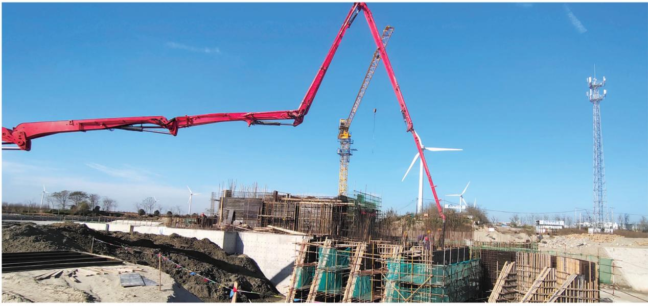
近日,小洋口海之城引水工程4.3米高程下水水工结构施工基本完成。为了确保明年4月份汛期来临之前将耕运河与海之城6.5公里的匡河相通,项目立即投入到闸身4.3米至9.15米高程钢筋砼施工、下游一二级翼墙的施工中。总投资2600万元的海之城引水工程设计宽6米,设计流量每秒4立方米,闸深南北向70米,东西14米,为钢筋混凝土结构,对整个海之城起到补水和排涝的作用。目前,引水闸上游、下游的进出口、护坡、护岸基本结束,接下来将实施4.3米以上土建部分的施工,有望在今年年底实现引水闸工程的顺利封顶,完成工期约在2022年2月底。
