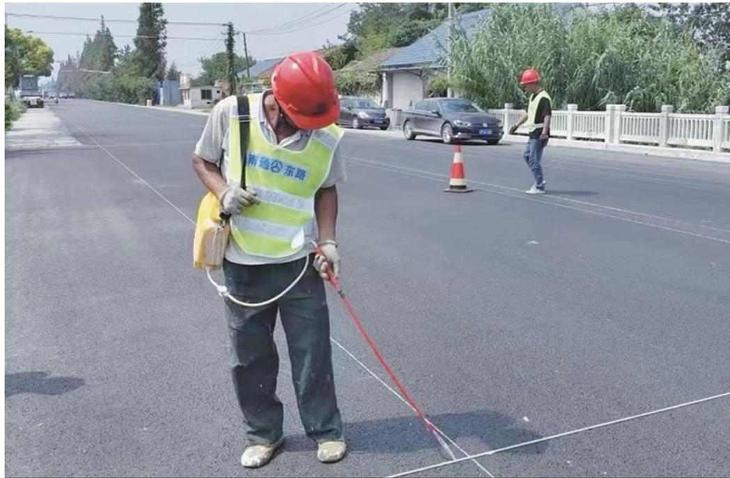
今年以来，县交通运输局实施县道大中修工程，为全县社会生产和百姓生活提供安全的交通运输服务保障。目前，各项工程进展顺利。洋兴线大中修项目现场一派热火朝天的施工景象，工人正在铺设好的沥青路面上画设标线。洋兴线因为年久失修，再加上是我县的交通要道，来往车辆较多，路基存在一定的损坏，今年县交通运输部门将该项目列入今年的民生实事项目。今年4月份开工建设后，工程进展迅速，上面层沥青铺设已完成80%，预计9月底完工，比原计划提前一个月。
