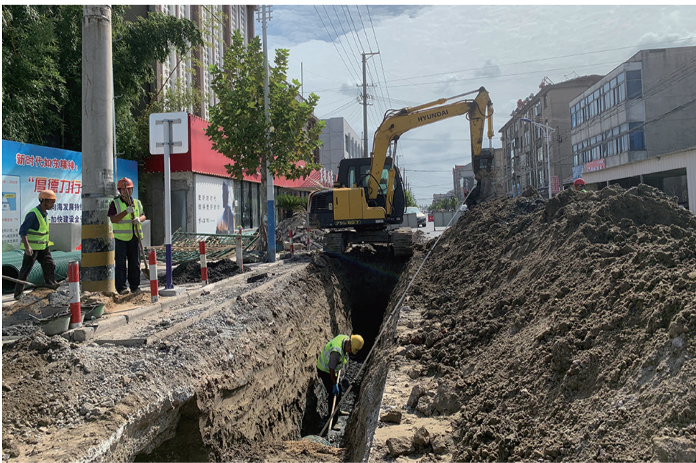
这几天,如东县东泽源水务工程有限公司的施工人员正在马塘镇市西西路挖掘污水支管网管道。马塘镇污水支管网建设工程主要分布于马丰南路、仁河南路、常青四季河沿岸等五个地块,全长约7公里,目前建设进展已超60%,预计11月底可全面竣工。
