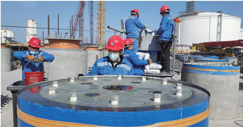
工人们正在进行储罐橡胶隔膜垫安装施工。 全媒体记者 徐书影 朱海城 摄
