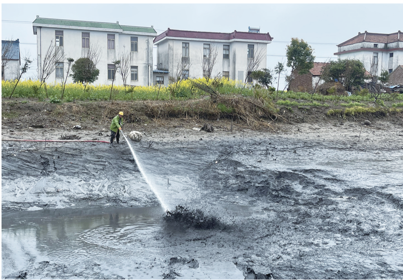
近日，在掘坎河河道清淤现场，工人们正架着高压水枪冲刷着淤泥，这是今年城中街道水利工程项目，预计4月底结束。项目总长7.2公里，疏浚土方量14万立方米。项目完成后，不仅能改善河道水质和生态环境，也能有效恢复河道引排功能，为农田灌溉做好准备，也为汛期防洪排涝工作打好基础。 全媒体记者 张颖 吴梦凡 摄
