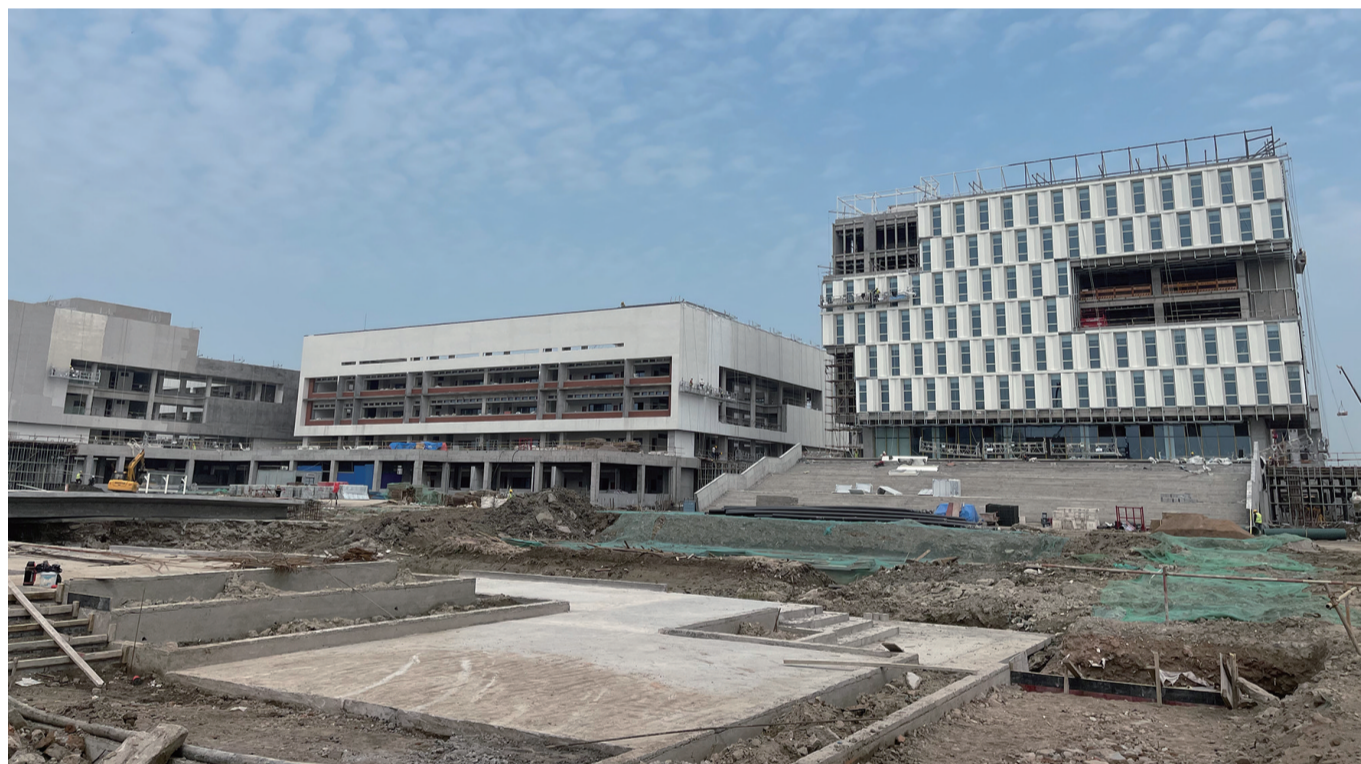
如东高级中学异地新建项目按普通高中四星标准设计建设,用地面积约221.5亩,总建筑面积10.35万平方米。当前,整个室内、外装修已经完成整体进度的60%,室外配套完成50%,绿化施工即将全面进场。项目计划今年6月底完工,7月底交付。
