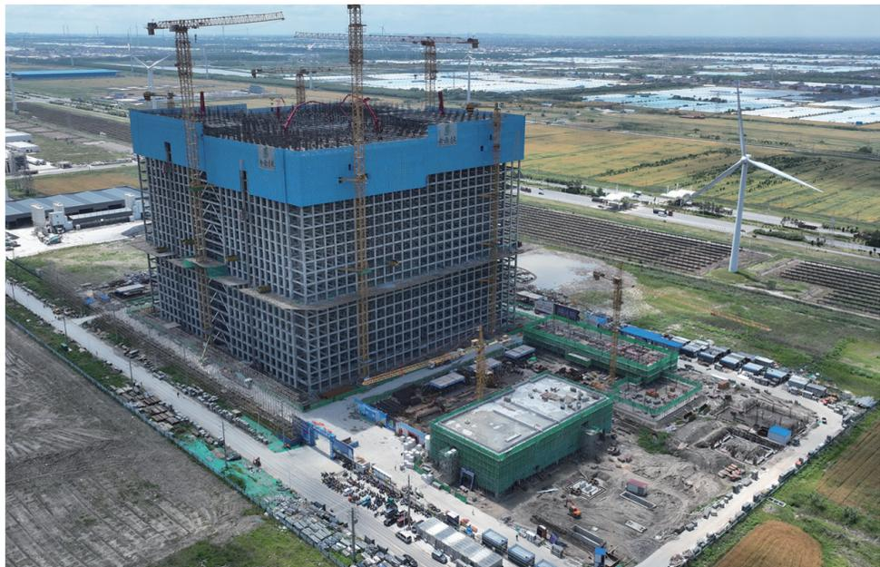
本报讯(全媒体记者 曹建明 张凯 张平)位于洋口镇的如东100兆瓦时重力储能项目是我国首个重力储能技术应用示范项目。连日来,工人们抢抓当前施工黄金期加紧建设,确保项目在今年底实现并网发电。
