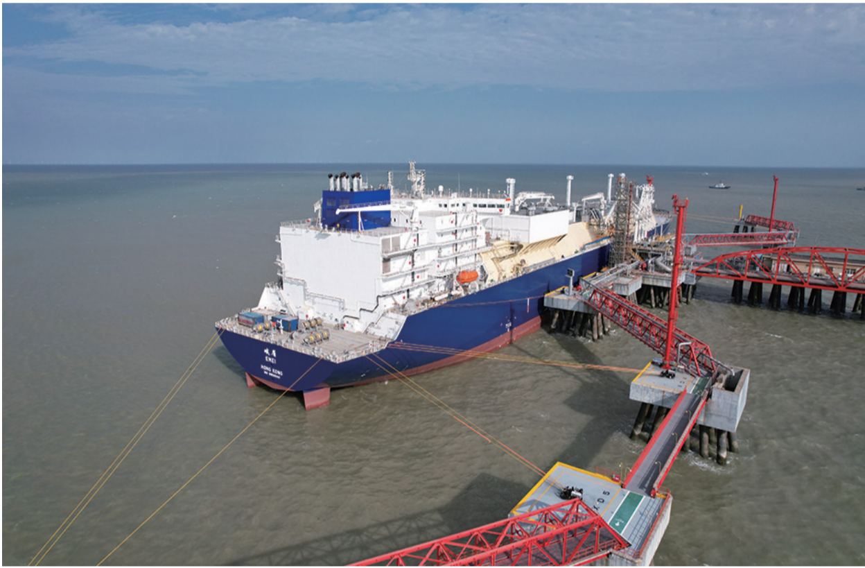
图为“峨眉”号在中石油江苏 LNG 接收站气试现场。
