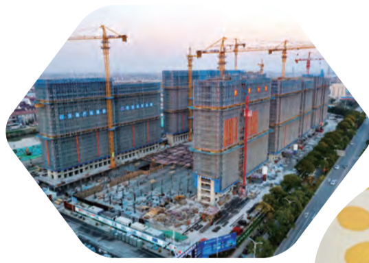
72#D安置房项目现场
