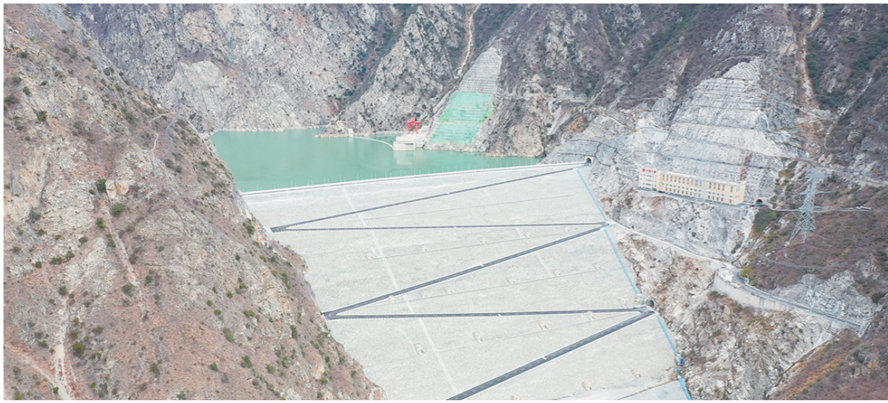
甘孜州大唐国际甘孜公司长河坝电站
