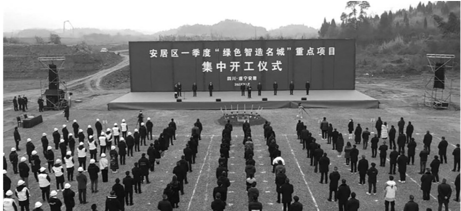
开工仪式现场
