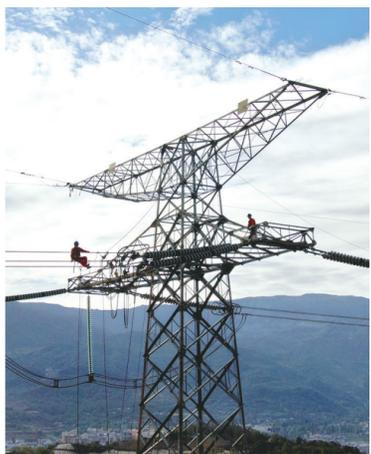
2021年6月4日，国网四川送变电公司承建的白鹤滩配套布拖二期工程π接点，电力工人正在上横担将新建线路导线搭接到旧塔上（刘湘帆摄）
