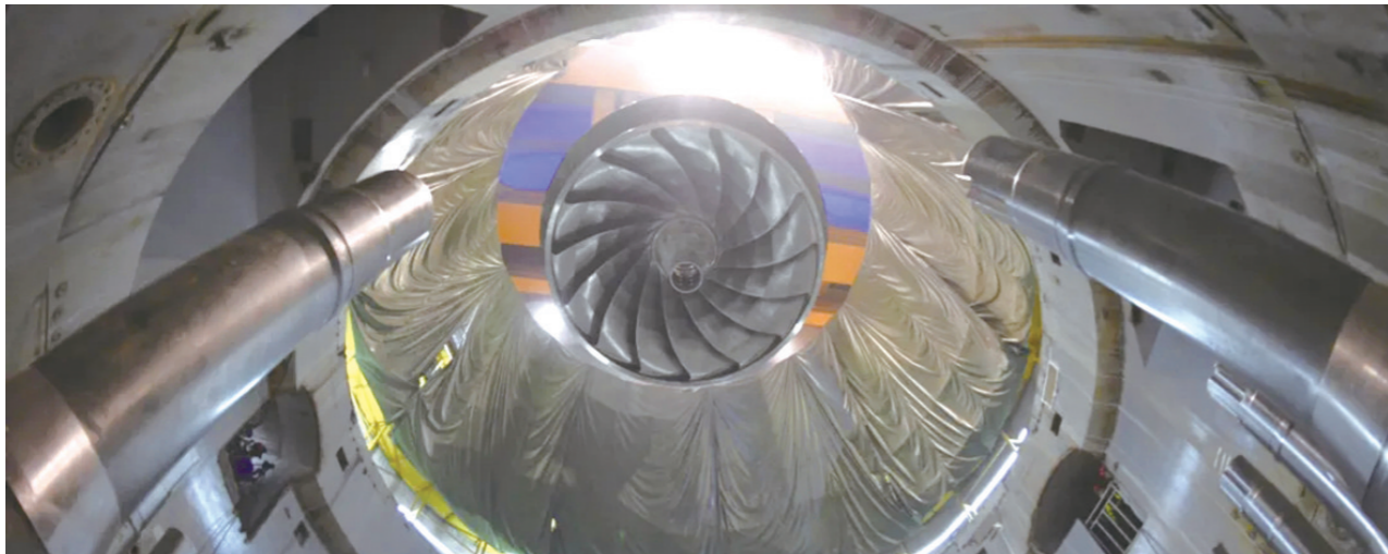
东电生产的白鹤滩首台转轮吊装
