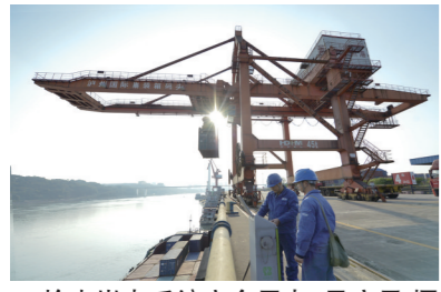
检查岸电系统安全用电 马宁果 摄
