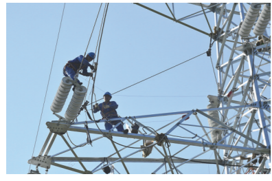
迎着高温建设电网 张跃 摄
