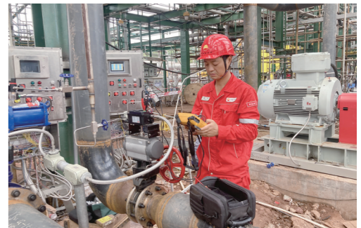
改造投运专家组成员温涛正在作业
