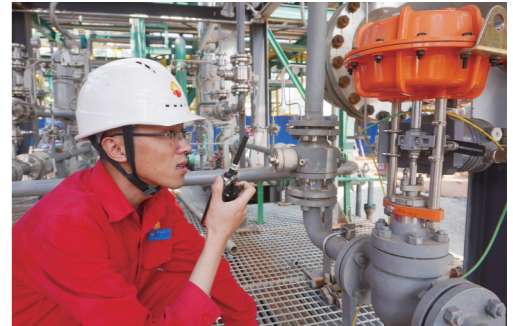
分厂净化工段工段长罗圣洁正在协调测试新建装置性能
