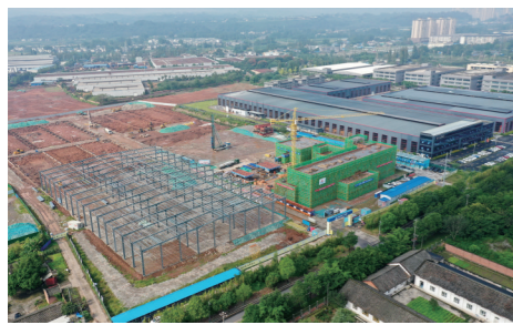
建设中的道达电动车项目
