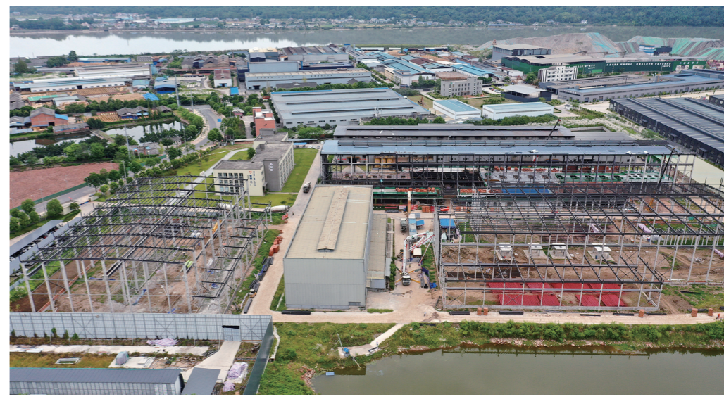
建设中的盛丰铝业智能车间升级改造项目
