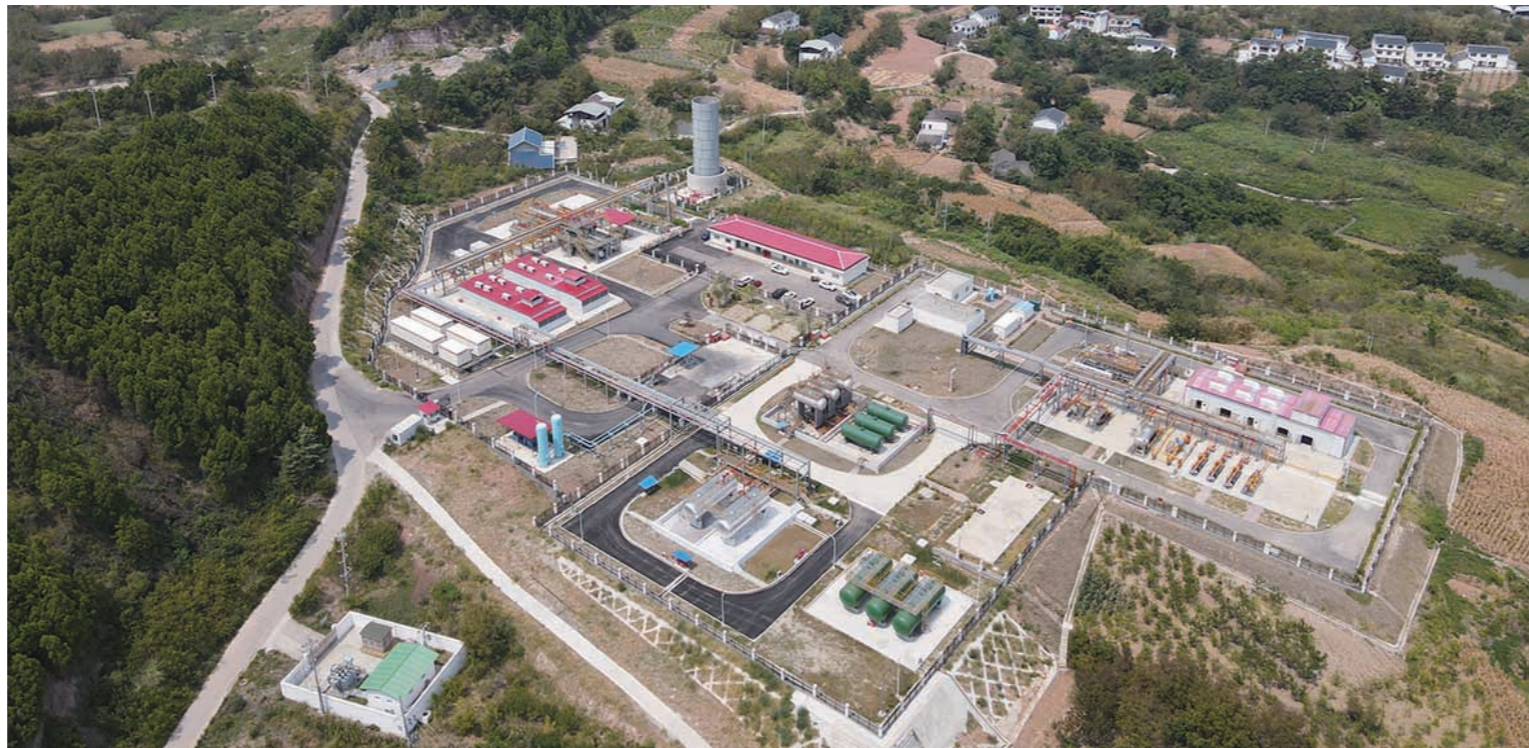
川中地区秋林区块致密气建设现场
