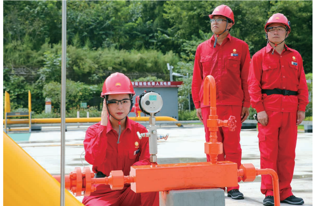
西南油气田员工头戴AR智能眼镜进行巡检工作(数字翔摄)
