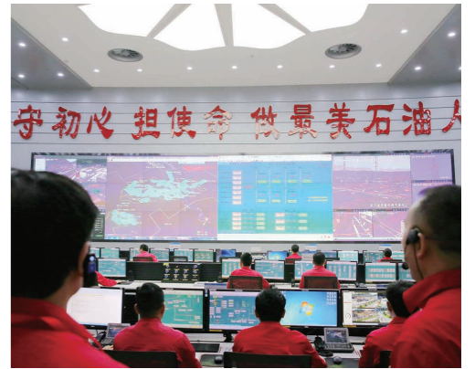
安岳气田龙王庙净化厂操控中心(图片由西南油气田公司提供)
