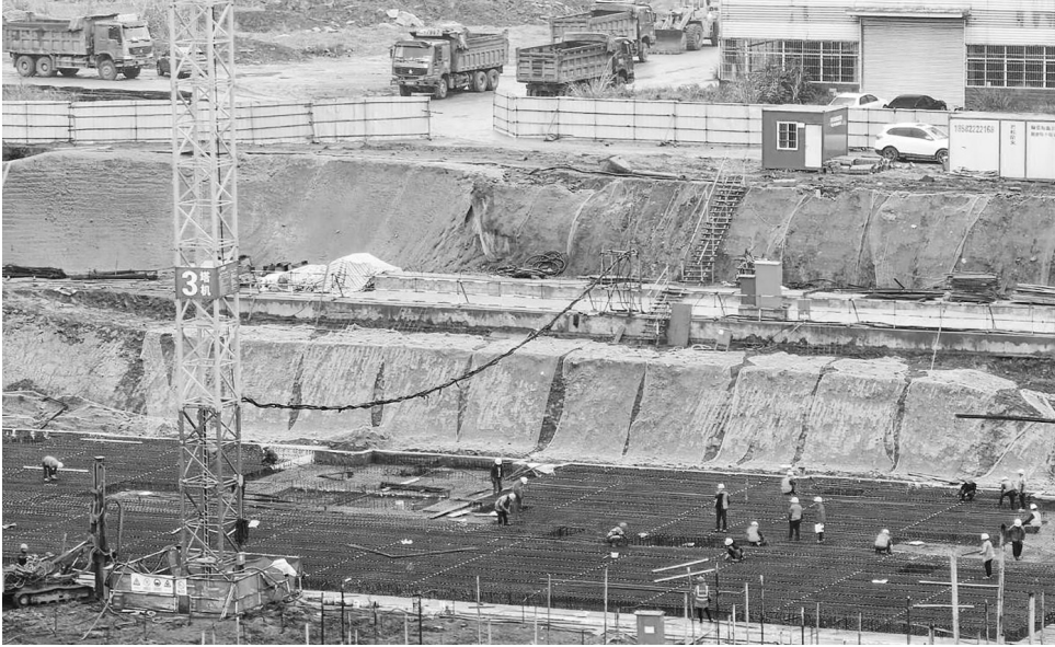
棚户区改造项目建设现场
