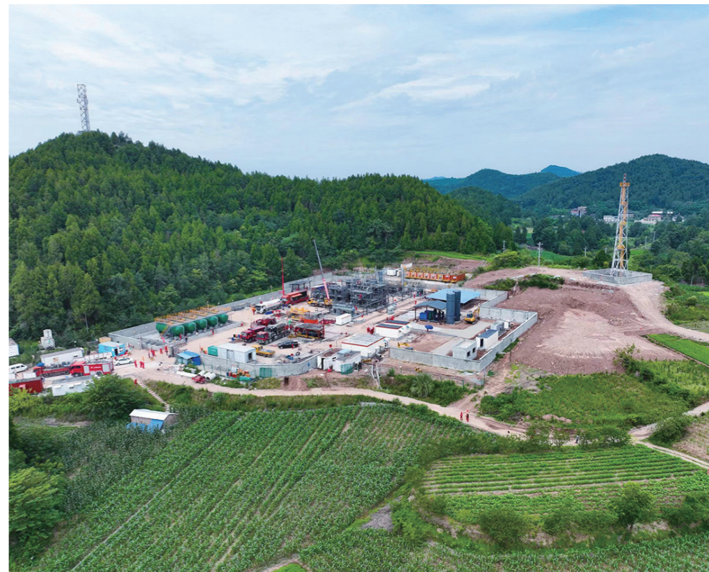
西南油气田公司蓬莱气区茅口组层首口超高压井勘探1井施工现场 (樊德伟 摄)
