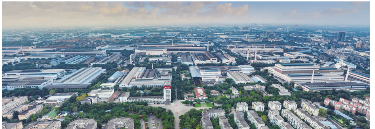
德阳经济技术开发区
