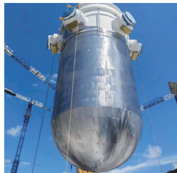
华龙一号批量首堆示范工程——漳州核电厂2号机组穹顶吊装成功
