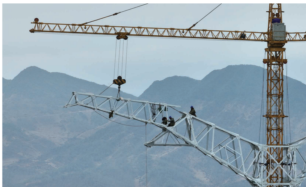
吊装作业现场 (国网四川电力供图)
