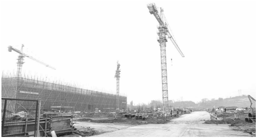
中昊晨光“2.6万吨/年高性能有机氟材料项目”施工现场
