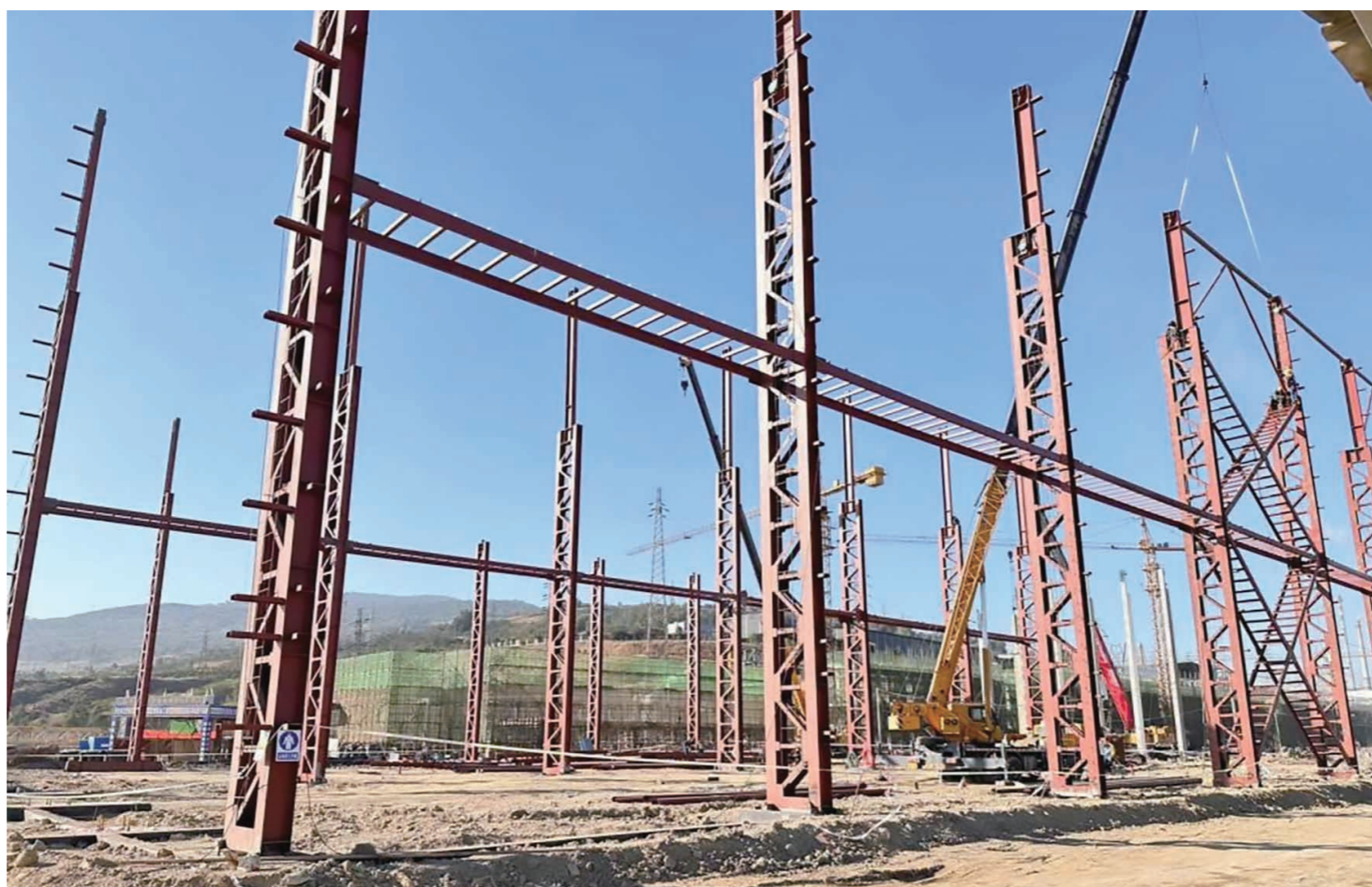
项目建设现场(攀枝花市经信局供图)
