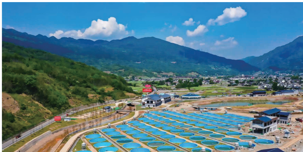
鱼跃龙门智慧水产养殖示范区项目现场
