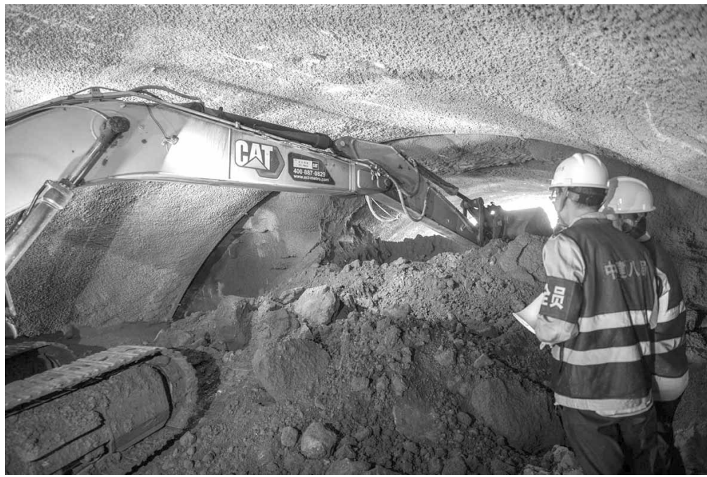
隧道贯通现场(中国铁路成都局集团有限公司供图)
