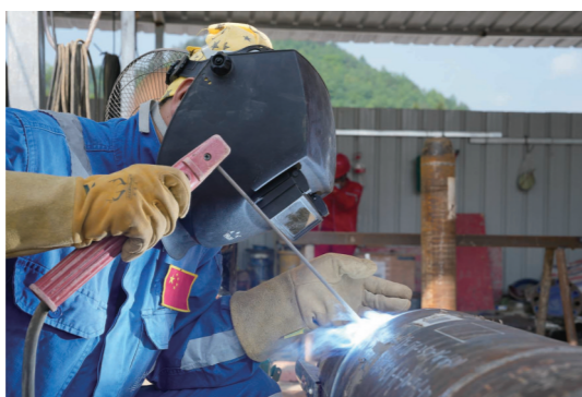
管道焊接作业(韩超摄)
