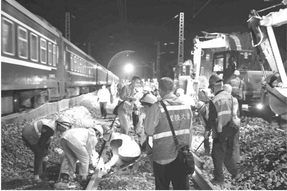
大修集中修现场(中国铁路成都局集团有限公司供图)
