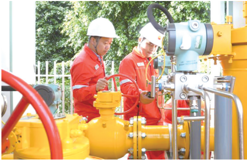
为“攀米线”沿线企业进行计量调压柜泄漏检测
