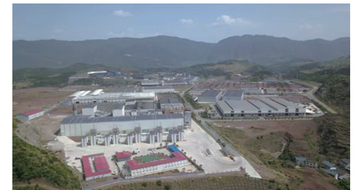
园区建设现场
