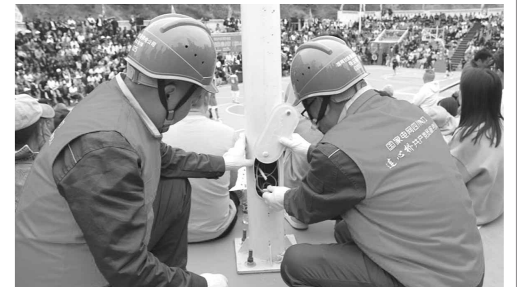
工作人员在比赛现场排查安全用电隐患
